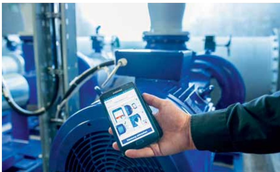
Рис. 5. Управление насосом через приложение KSB Sonolyzer®
