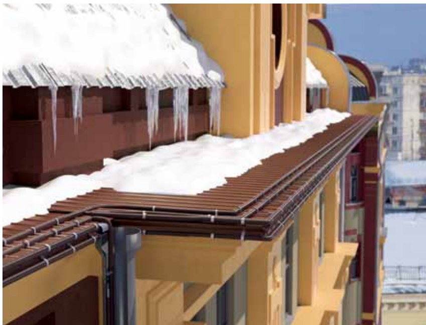
Рис. 1. Антиобледенительная система «Ледовый патруль» на основе нагревателя нового поколения
