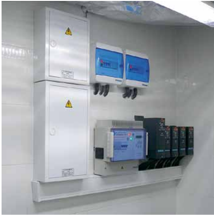
▲ Система управления вентиляцией: пример реализации
