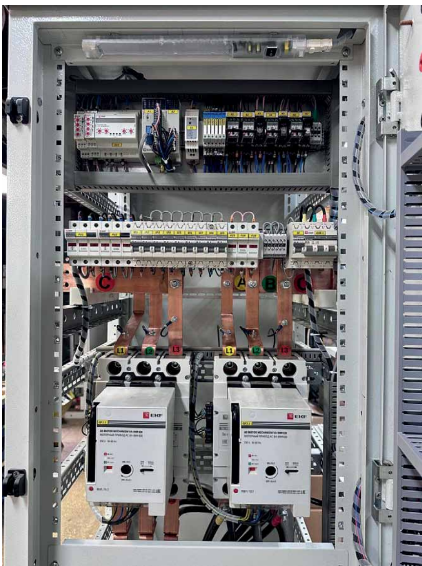
Рис. 2. АВР в системе энергоснабжения хлебозавода
