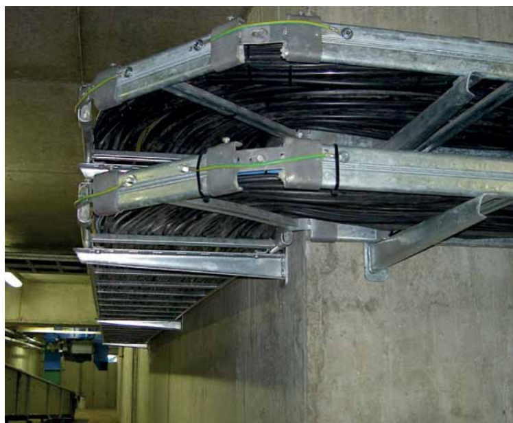
Рис. 3. Монтаж поворотов кабельной трассы требует применения специальных элементов
