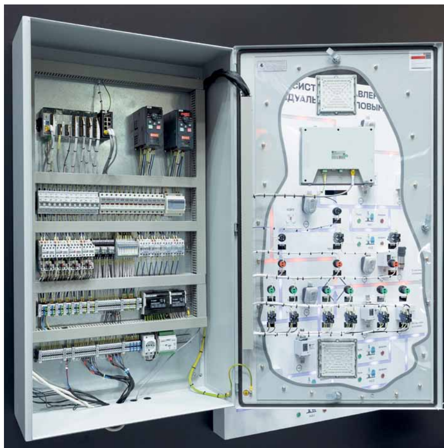
Рис. 1. Шкаф управления ИТП на основе продукции ЕКФ
