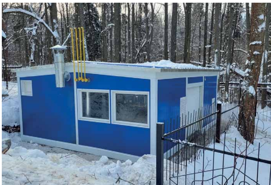
Рис. 1. Блочно-модульная отопительная котельная ИНТЕРБЛОК без дымовой трубы
