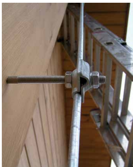
Рис. 3. Крепление круглого токоотвода молниезащиты 8 мм на стене
