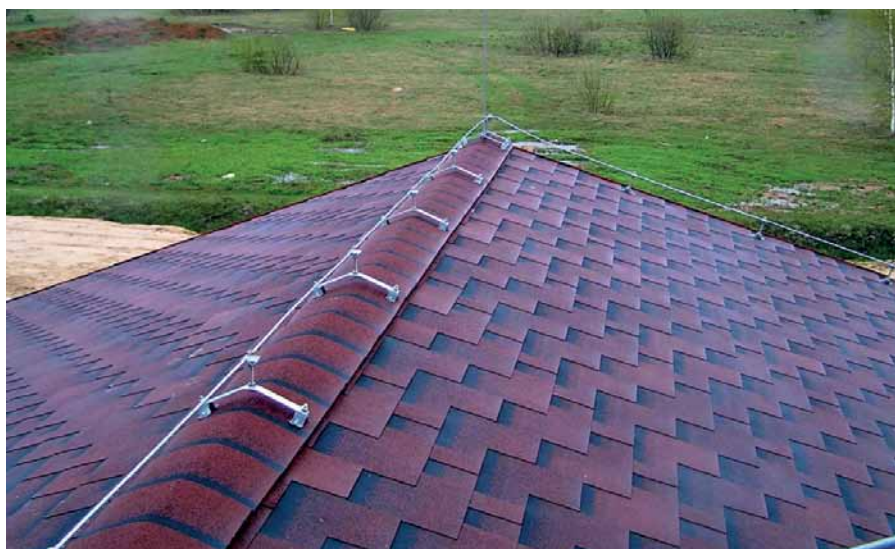
Рис. 4. Крепление токоотвода молниезащиты диаметром 8 мм на коньке и скате мягкой кровли коньковым держателем проводника КД-1.1-100-115 ГЦ и держателем проводника кровельным ДПК-100 ГЦ
