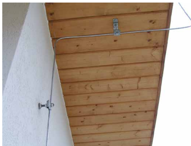
Рис. 2. Крепление круглого токоотвода молниезащиты 8 мм
