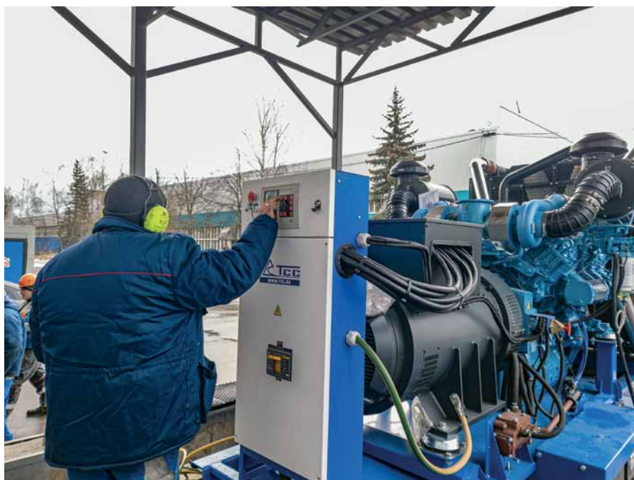
Рис. 2. Управление с помощью HMI-панели
