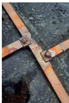
Рис. 2. Примеры соединений, выполненных по технологии термитной сварки
