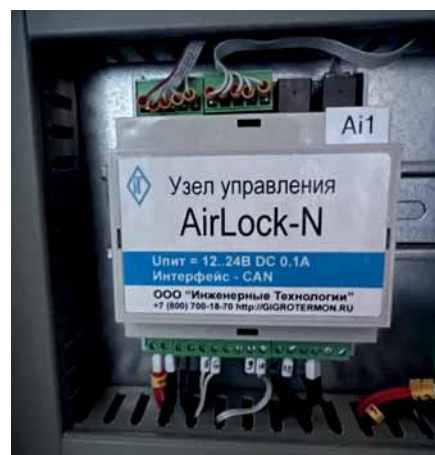
Рис. 1. Узел управления замками AirLock-N
