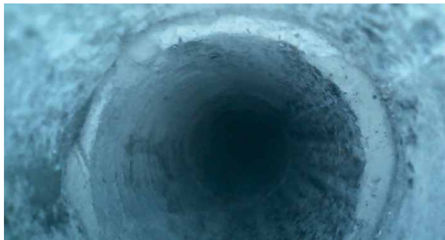
Рис. 2. Съемка эндоскопом внутри скважины
