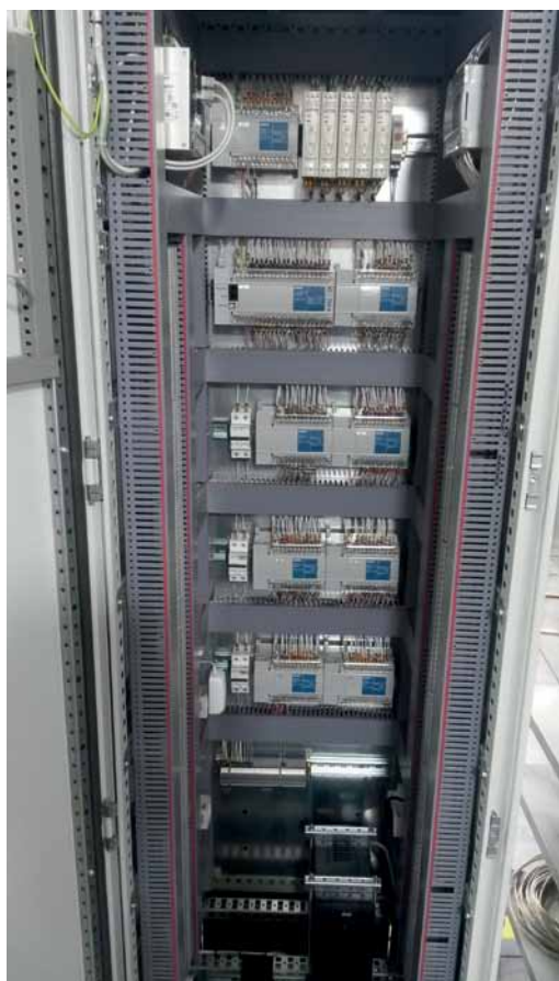
Рис. 2. Шкаф управления вентиляцией на базе оборудования ОВЕН
