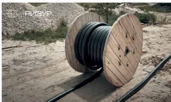
Рис. 3. Катуха с трубой РИЗУРПАК-ЖКХ на объекте
