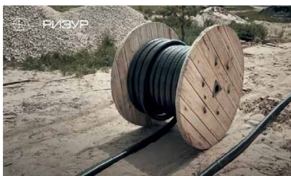
Рис. 3. Катужка с трубой РИЗУРПАК-ЖКХ на объекте
