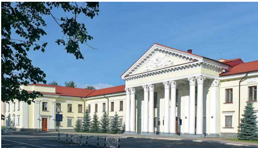
Рис. 1. Уральский электрохимический комбинат: здание заводского управления
