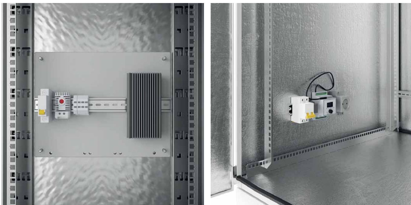
Рис. 2. Шкаф климатический 19-дюймовый серии SRT03: внутренняя оснастка
