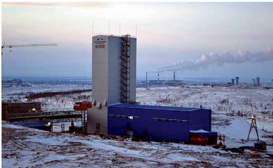
Рис. 1. Молниеприемники ELMASHTM® на надшахтном сооружении
