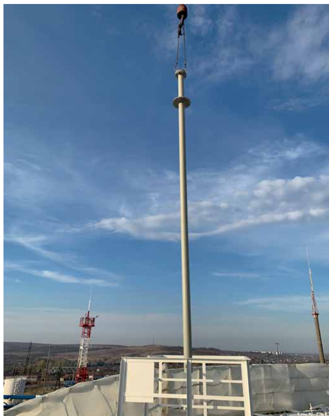
Рис. 3. Установка измерительной трубы радиоволнового уровнемера РДУЗ-40 на резервуар с помощью крана-манипулятора
