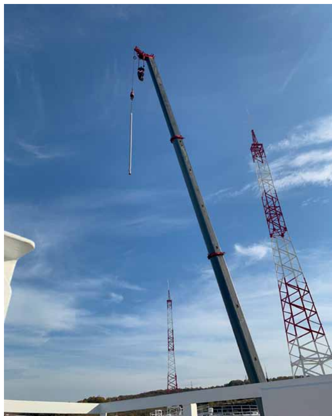
Рис. 3. Установка измерительной трубы радиоволнового уровнемера РДУЗ-40 на резервуар с помощью крана-манипулятора
