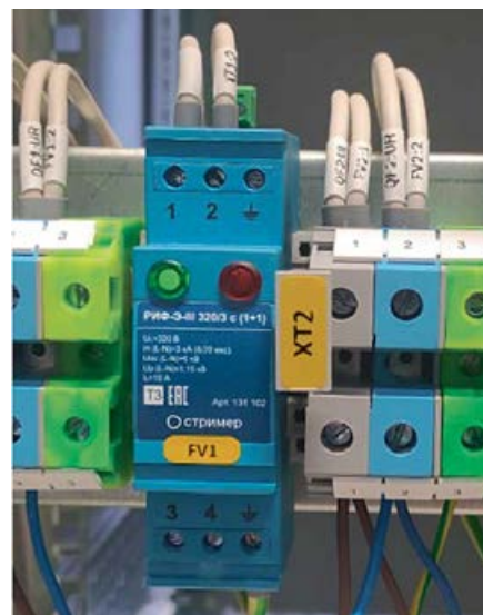
Рис. 1. Монтаж УЗИП на DIN-рейку
