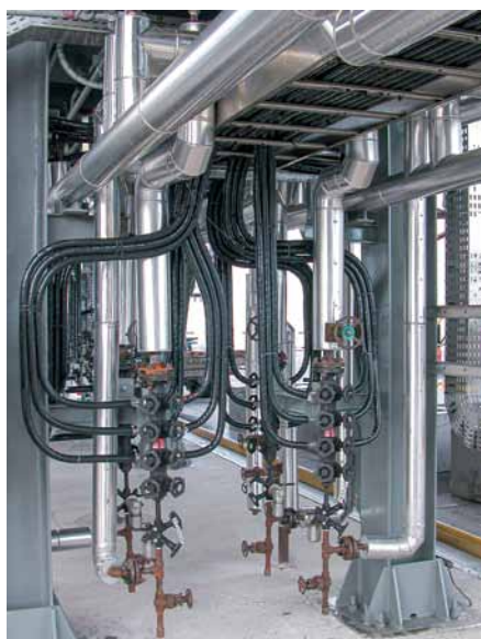
Рис. 5. Пример монтажа утепленных предизолированных импульсных трубок на объекте
