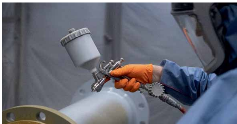
Рис. 1. Процесс лакокрасочных работ на предприятии «ГК УЛЬТРА»
