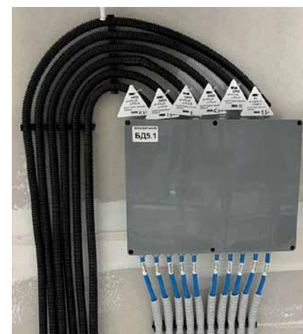
Рис. 7. Блок с датчиками дифференциального давления ИПМ-41-03-1-1
