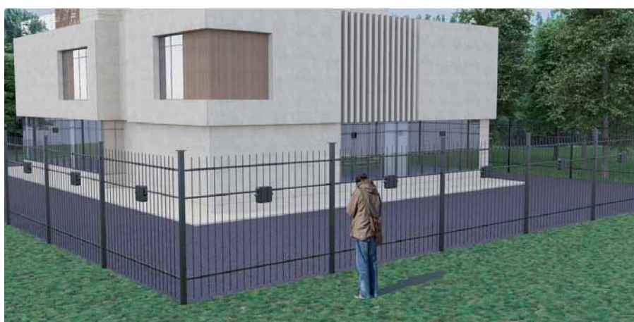
Рис. 3. Пример установки вибрационных датчиков системы Triboniq™
