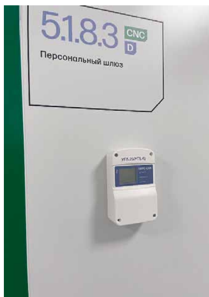
Рис. 5. Проводной узел «Пирс-CAN»: примеры скрытого монтажа для чистых помещений
