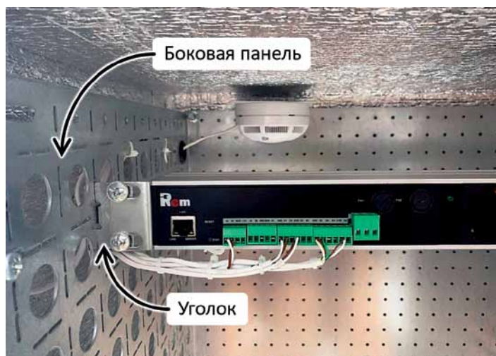
Рис. 2. Решения для крепления оборудования 19-дюймового стандарта: а – фрагмент укомплектованного шкафа ШТВ-Н; б – внешний вид боковой панели и уголков
