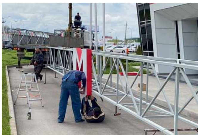
Рис. 3. Несущие конструкции для вывески
