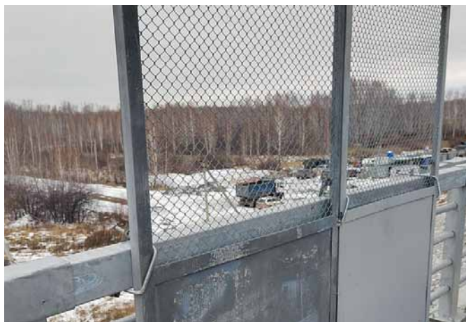
Рис. 7. Защитные ограждения надземного перехода
