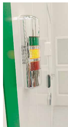
Рис. 3. Световая колонна, управляемая узлом «Пирс-CAN»
