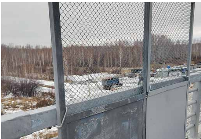
Рис. 7. Защитные ограждения надземного перехода
