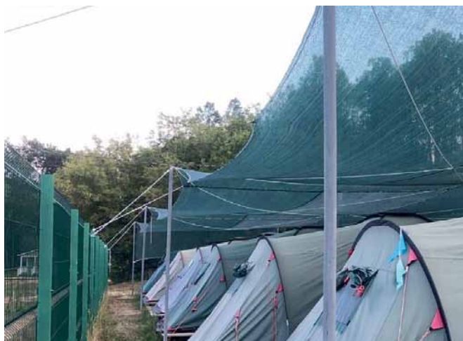
Рис. 1. Опорные столбы в палаточном лагере
