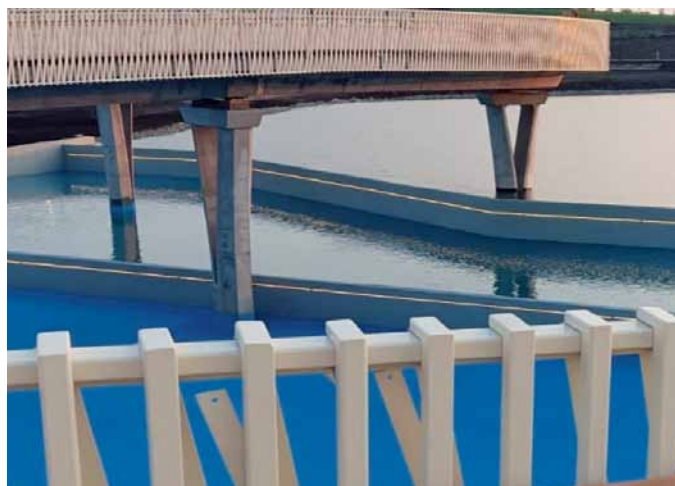
Рис. 2. Ограждения на берегу водоема
