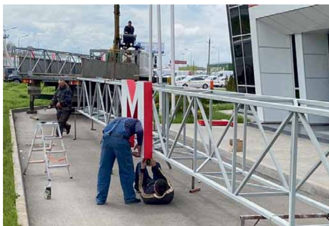
Рис. 3. Несущие конструкции для вывески
