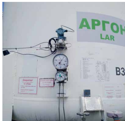
Рис. 4. Мониторинг давления и аварийных событий в цистернах с жидким аргонem в режиме интерактивной карты с оперативным выводом мини-отчета через веб-интерфейс системы диспетчеризации PROMODEM CLOUD
