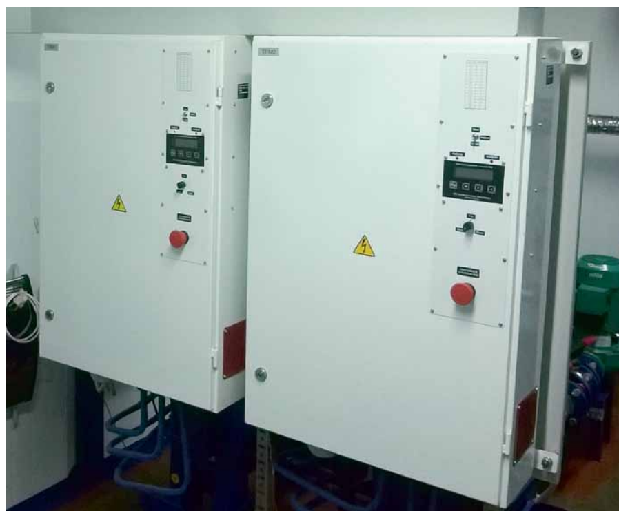
Рис. 1. Тиристорный регулятор переменного напряжения серии ТРМ в котельной
