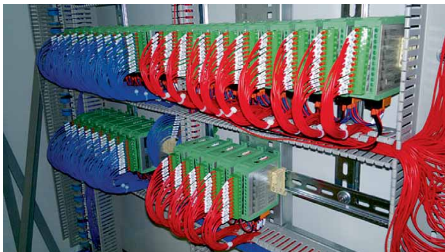
Рис. 4. Реализация функционально распределенной структуры для пространственно централизованного исполнения ПТК «УМИКОН» на модулях серии «Ока»
