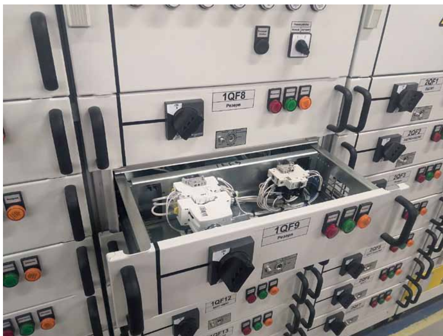
Рис. 2. Отсек НКУ с извлеченным модулем
