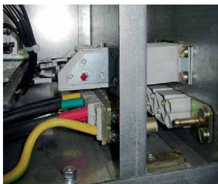
Рис. 2. Наборный соединитель СПН1 и прямоугольный модульный соединитель СПМ в рамке на панели выдвижного модуля НКУ
