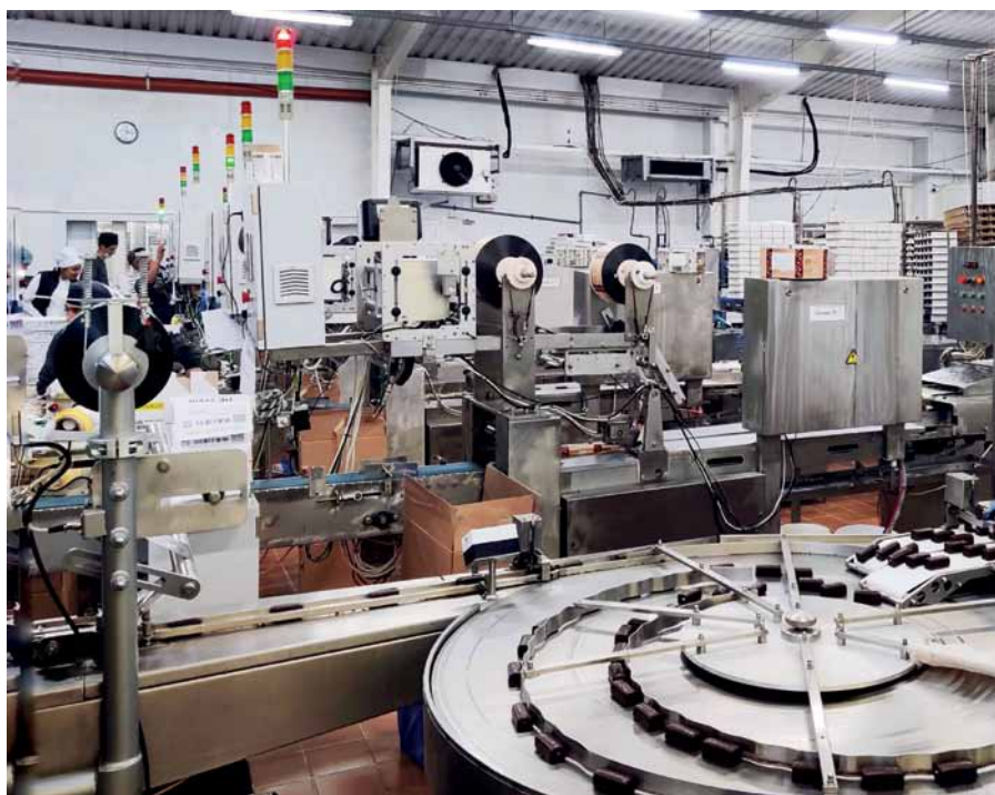
Рис. 1. Светосигнальные колонны MEYERTEC на технологической линии
