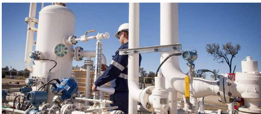
Рис. 2. Работа на объекте компании Westside Corporation Pty Ltd
