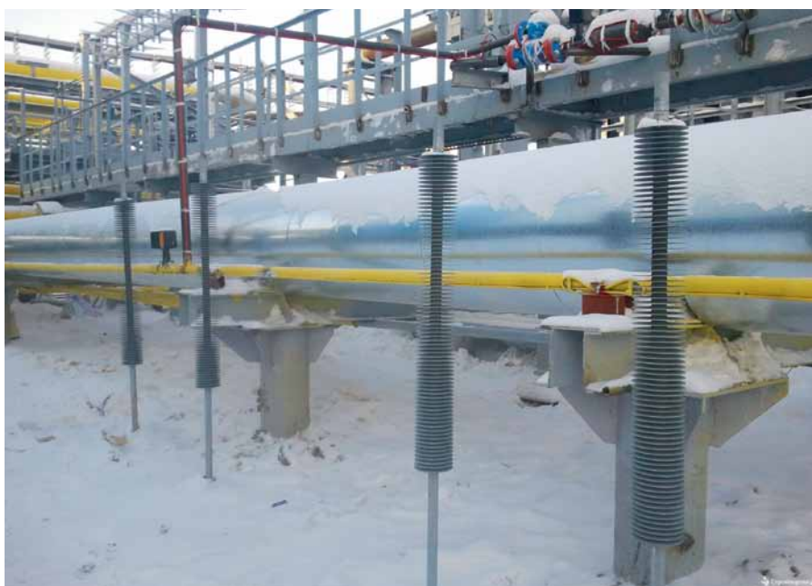
Рис. 2. Примеры объектов, обработанных составом класса Zinker: а – Волжская ГЭС: состав нанесен воздушным способом в два слоя; б – термостабилизаторы (Ямал), состав нанесен в два слоя общей толщиной 80 мкм
