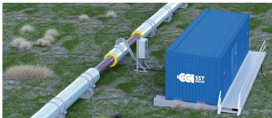
Рис. 2. Система VeLL на трубопроводе
