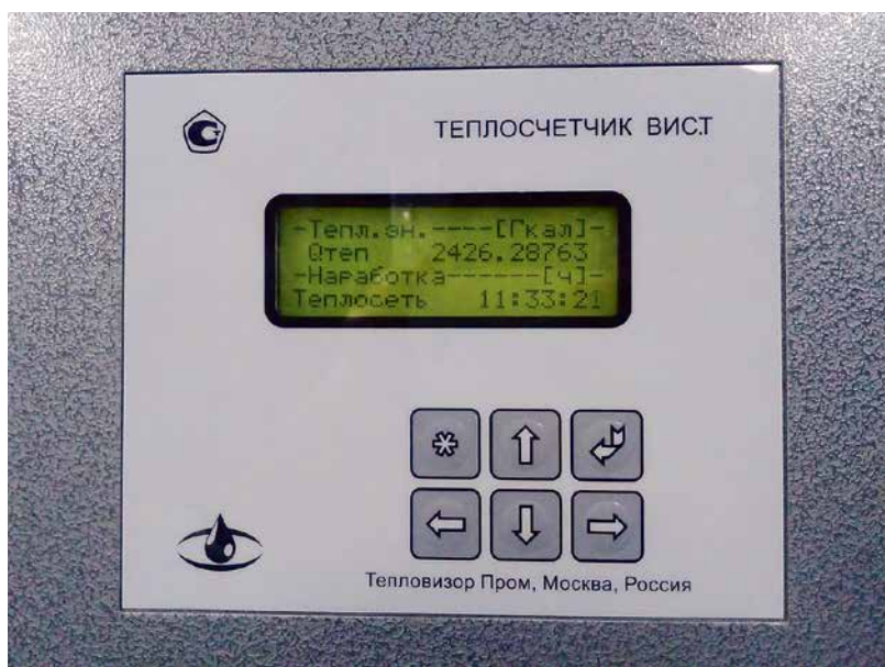
Рис. 3. Внешняя панель счетчика ВИС.Т с ЖК-дисплеем
