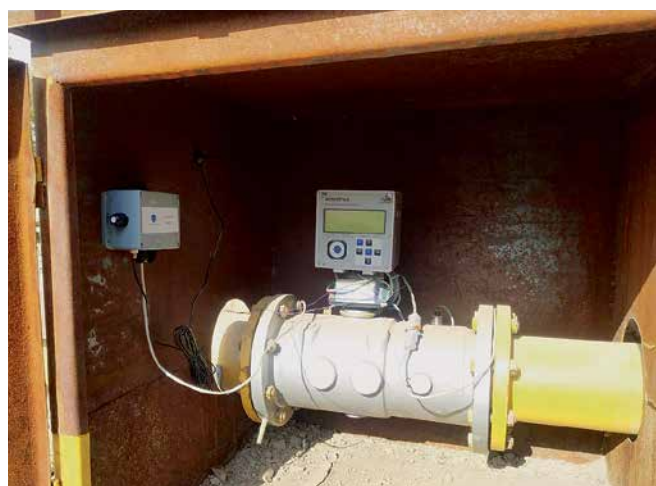
Рис. 6. Подключение автономного газового корректора к батарейному модему PROMODEM GSM-125.09M для периодического опроса
