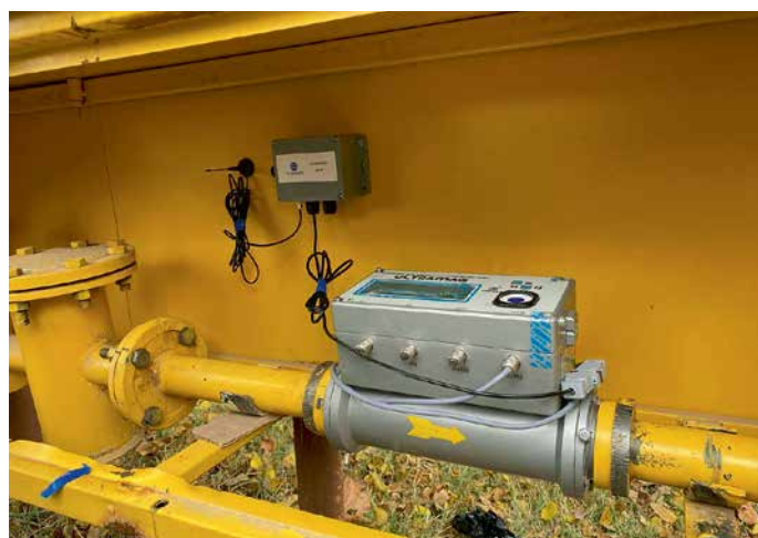
Рис. 6. Подключение автономного газового корректора к батарейному модему PROMODEM GSM-125.09M для периодического опроса
