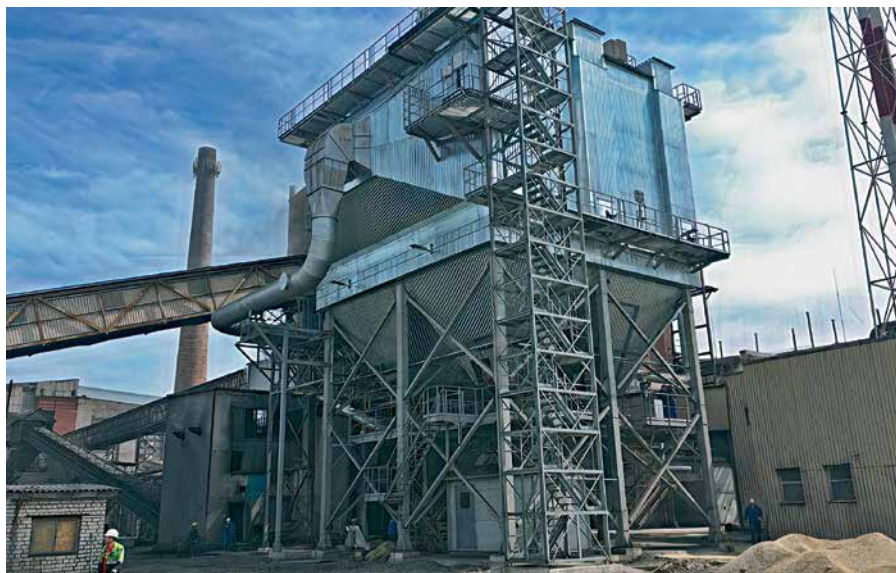
Рис. 1. Электрофильтры «ФИНГО»: а – на Бийской ТЭЦ; б – в г. Кивиули, Эстония
