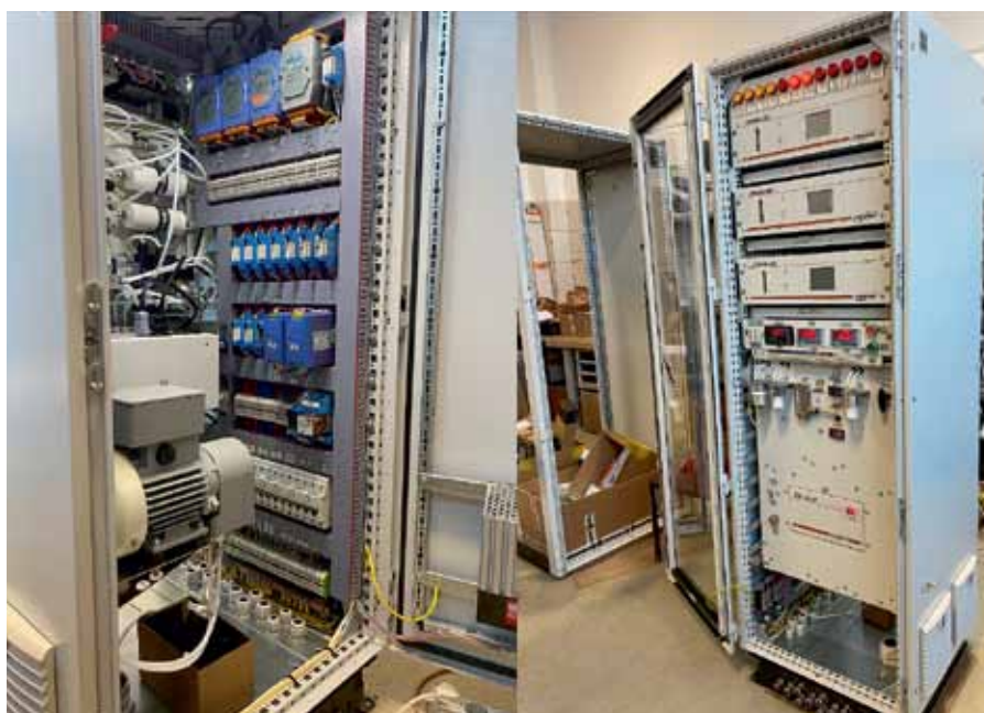
Рис. 3. Система экологического контроля (АСЭК) на основе газоанализатора «ГАММА-100» для контроля O_2 , CO , CO_2
