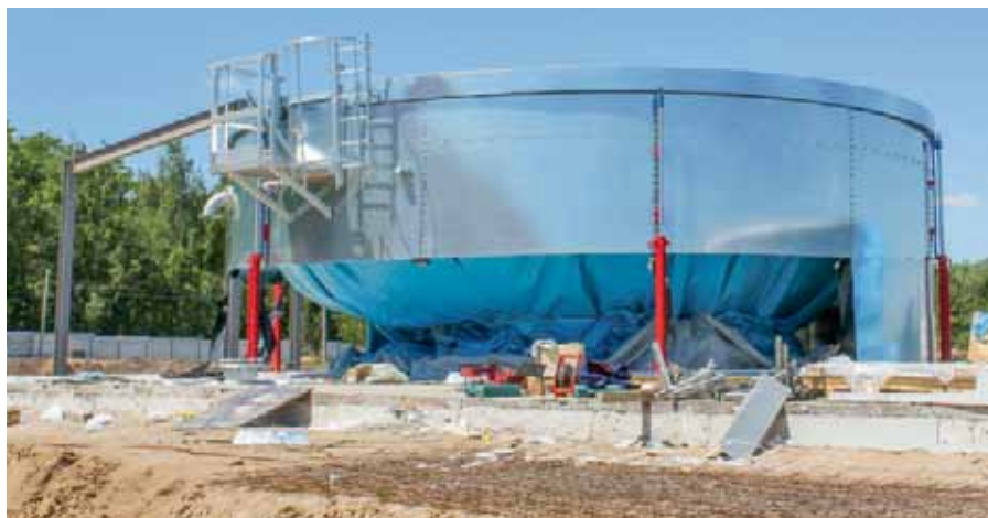
Рис. 3. Возведение и монтаж резервуара: внутри расположена ПВХ-мембрана, которая не соприкасается с металлическими стенками
