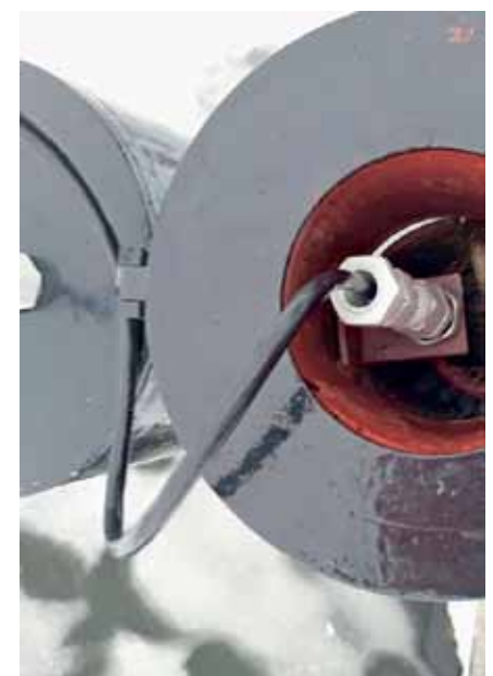
Рис. 7. Удаленная настройка логгера PROMODEM без выезда на объект: логгер сам заберет настройки при плановой передаче архивов измерений на сервер диспетчерской (или при внеочередной отправке аварийного архива)
