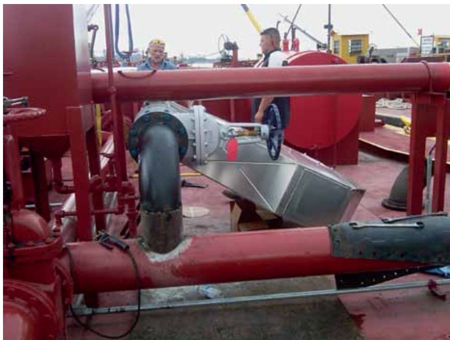
Рис. 4. Массовый кориолисовый расходомер RHEONIK на палубе танкера в нестандартном положении
