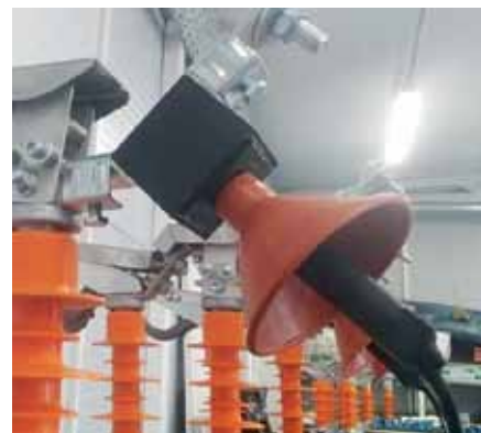
Рис. 5. Внешний изолированный резистивный балласт P1-1 с ограничителем напряжения для линии 6(10) кВ (слева); внешняя накладная катушка Роговского для шины 32 мм линии 6(10) кВ для бесконтактного съема информации о протекающем токе (справа)
