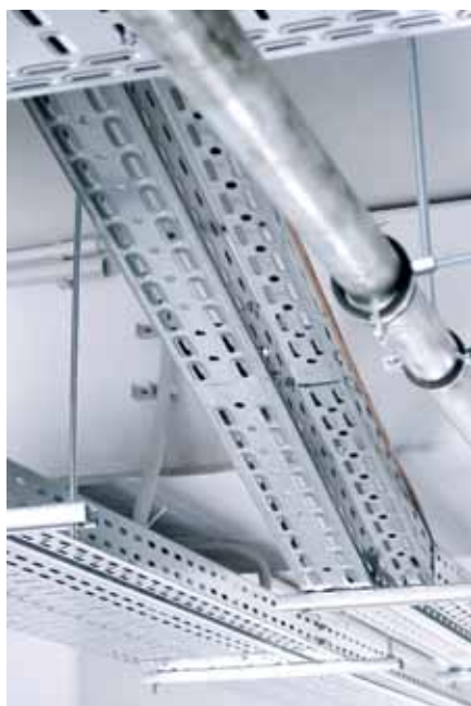
Рис. 3. Металлическая кабеленесущая система KOPOS
