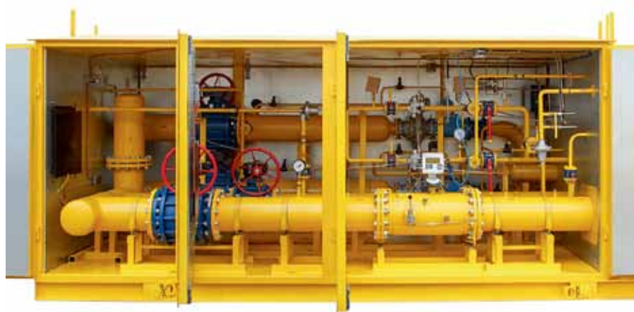
Рис. 2. ПУРДГ производства ООО «ЭЛЬСТЕР Газэлектроника» (г. Арзамас)
