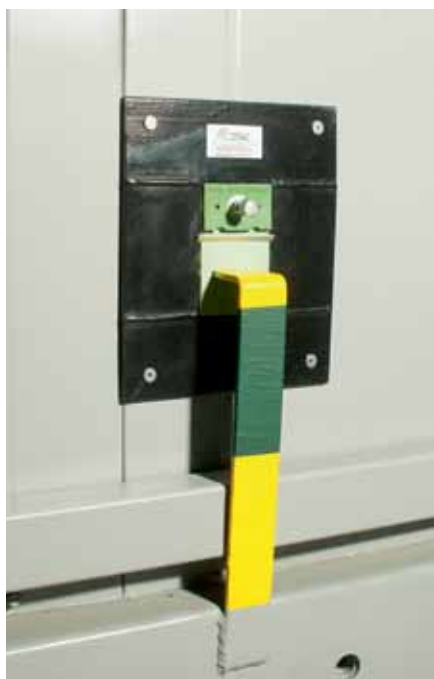
Рис. 4. Вывод полосы заземления
