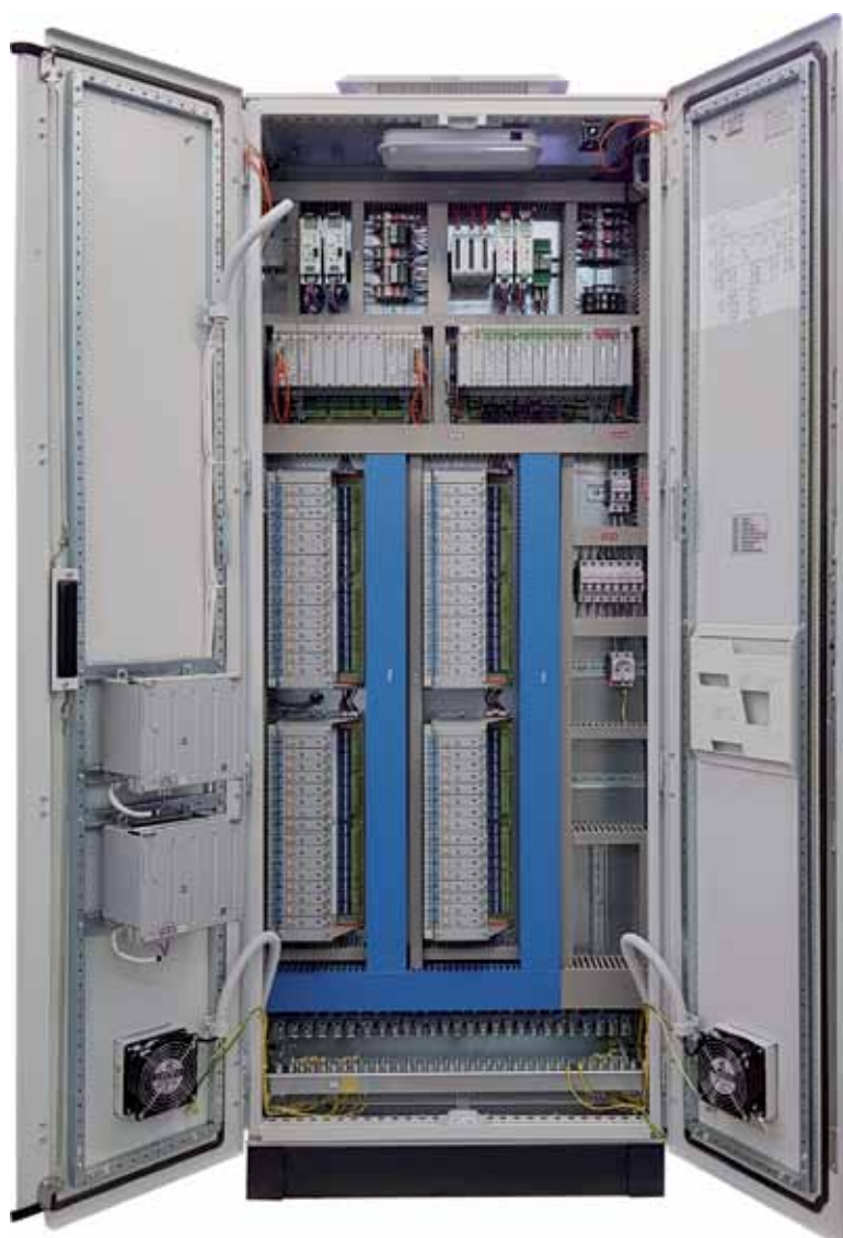
Рис. 1. Типовой шкаф УСО на базе модулей МКСО
