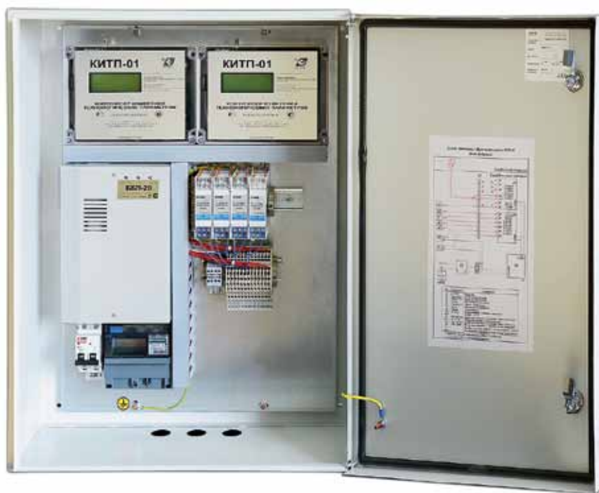
Рис. 2. Каскадирование КИТП-01
