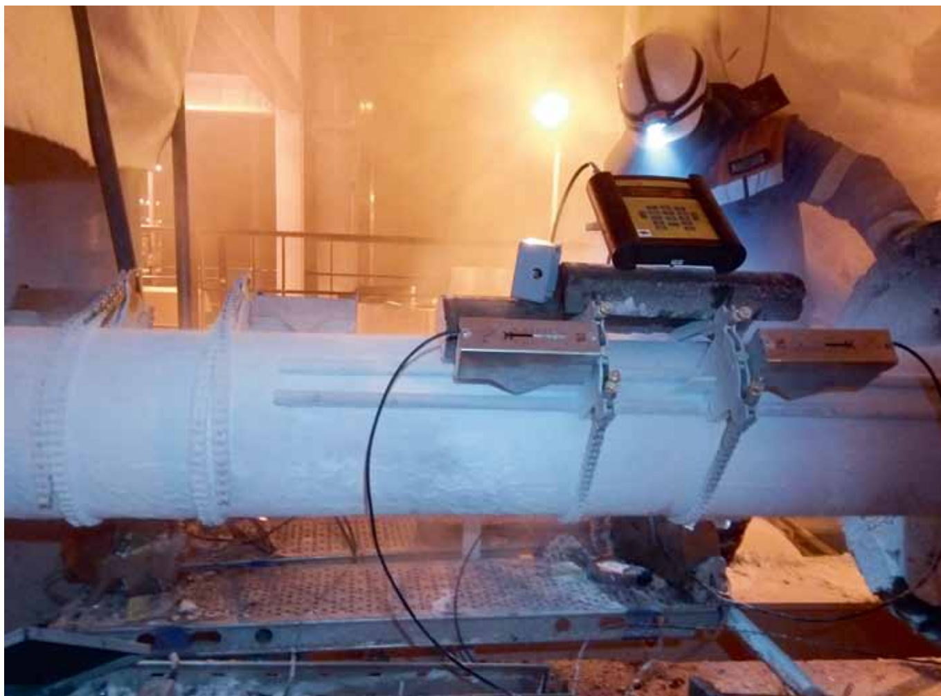
Рис. 2. Монтаж расходомера на трубе с криогенной жидкой средой
