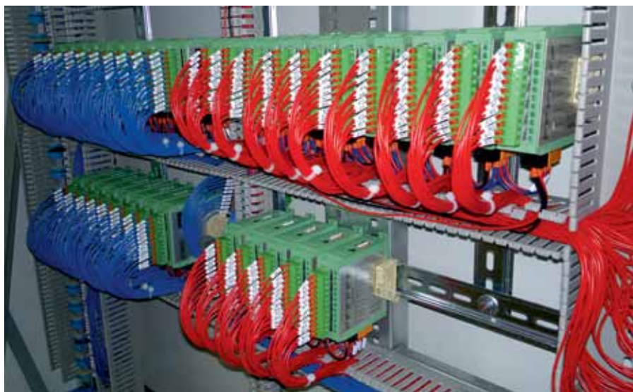
Рис. 3. Модули ввода/вывода комплекса «УМИКОН» на DIN-рейках
