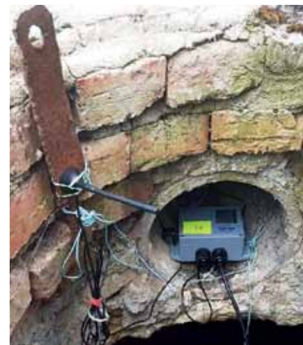
Рис. 6. Узел дистанционного контроля уровня воды в резервуаре на базе комплекта «Ультразвуковой датчик уровня PROMODEM GSM»
