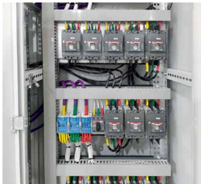
Рис. 4. Для крепления автоматических выключателей, пускателей и другого оборудования применяются резьбовые заклепки, которые устанавливаются в монтажные платы с помощью специального инструмента. Установка резьбовых заклепок позволяет быстро заменять то или иное оборудование. Данное решение особенно удобно, если доступ имеется только с одной стороны, и обеспечивает не только комфорт в работе, но и скорость монтажа
