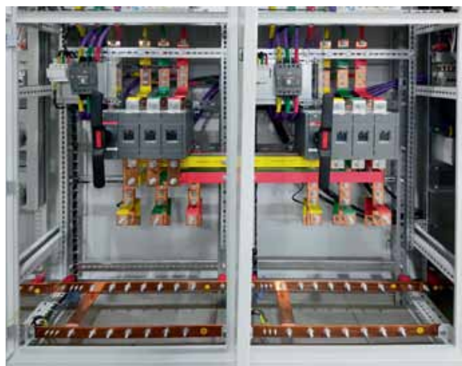
Рис. 2. Соединение перекидных рубильников между собой на вводных панелях выполняется медными заизолированными шинами. Разное цветовое исполнение изоляции позволяет специалисту быстрее ориентироваться в электрической схеме щита, а также повышает безопасность работы
