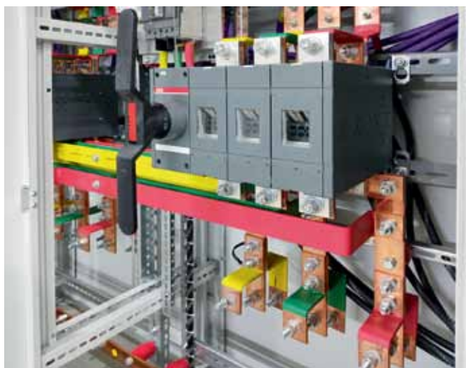
Рис. 1. Для производства шкафов используются болты класса прочности только 8.8, хотя по ГОСТ допустимо 5.8. Также в целях повышения надежности электрического соединения применяются тарельчатые шайбы, а не гровер
