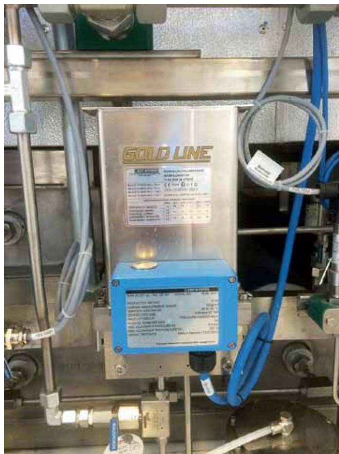
Рис. 1. Расходомер RHEONIK на водородной заправке
