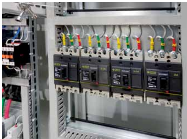
Рис. 6. На срез металла для предотвращения повреждения изоляции проводов в процессе эксплуатации изделия крепится защитная лента. Данное решение используется почти на всех острых кромках корпуса и различных системах крепления
