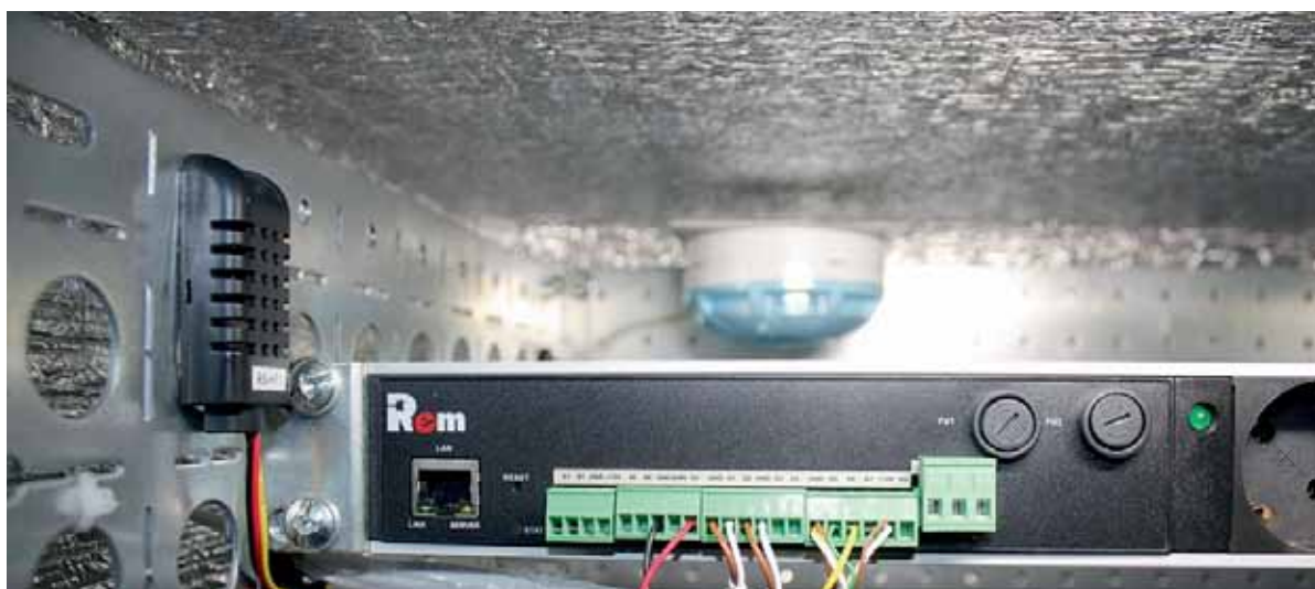
Рис. 1. Схема всепогодного шкафа с функцией удаленного мониторинга и управления
