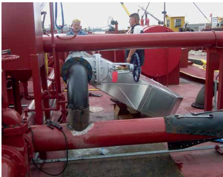
Рис. 2. Расходомер RHEONIK на палубе в нестандартном положении
