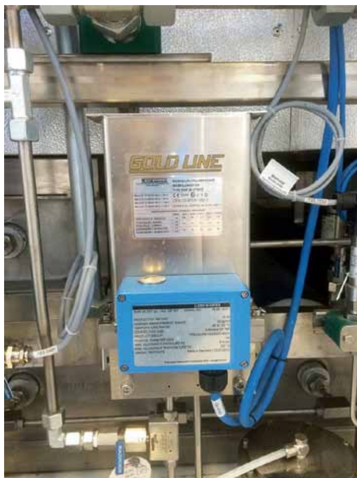
Рис. 1. Расходомер RHEONIK на водородной заправке
