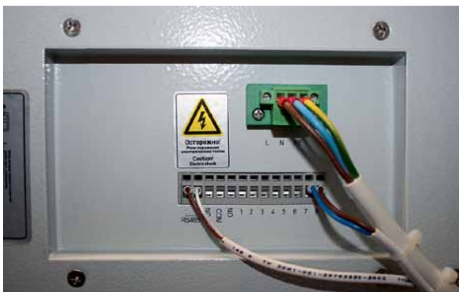
Рис. 5. Подключенный к системе мониторинга кондиционер
