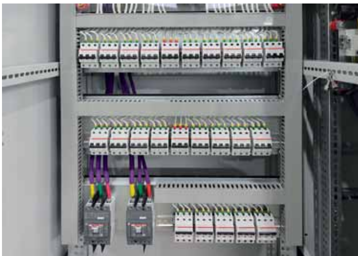
Рис. 9. Для прокладки кабельных трасс между различными компонентами автоматики используются сертифицированные негорючие кабель-каналы
