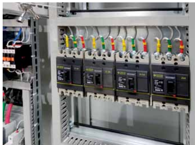
Рис. 6. На срез металла для предотвращения повреждения изоляции проводов в процессе эксплуатации изделия крепится защитная лента. Данное решение используется почти на всех острых краях корпуса и различных систем крепления
