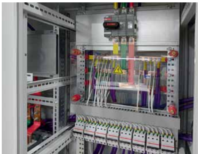
Рис. 3. Все токоведущие части закрыты негорючим поликарбонатом для предотвращения случайных прикосновений
