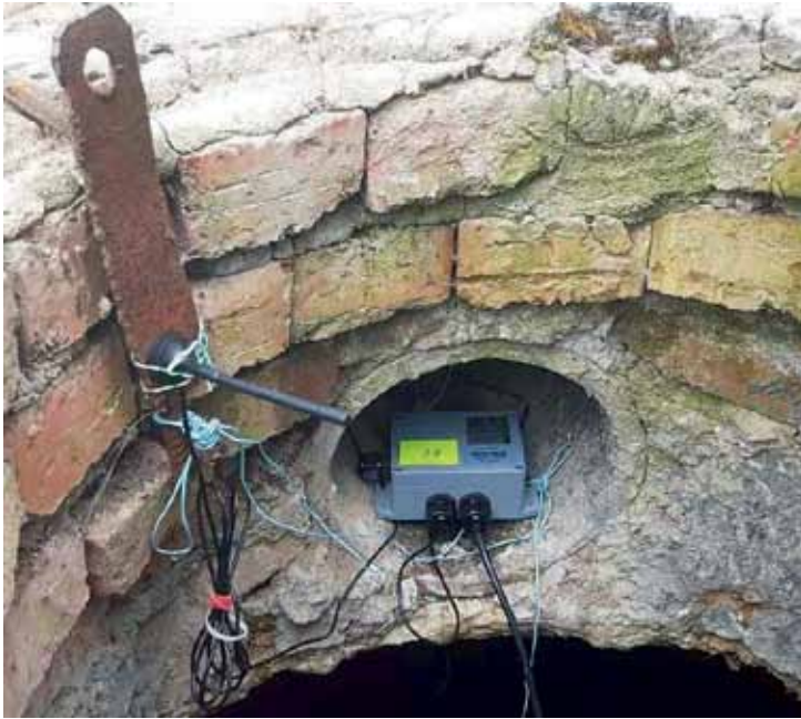
Рис. 8. Узел контроля уровня воды в резервуаре на базе Zulu-датчика (логгера) PROMODEM
