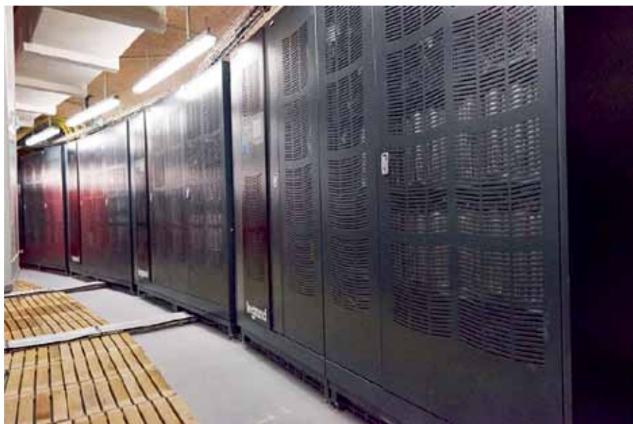
Рис. 2. В параллель можно подключать до шести ИБП Keor HP
