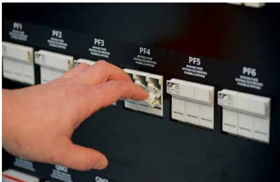
Рис. 4. Замена предохранителя PF4
