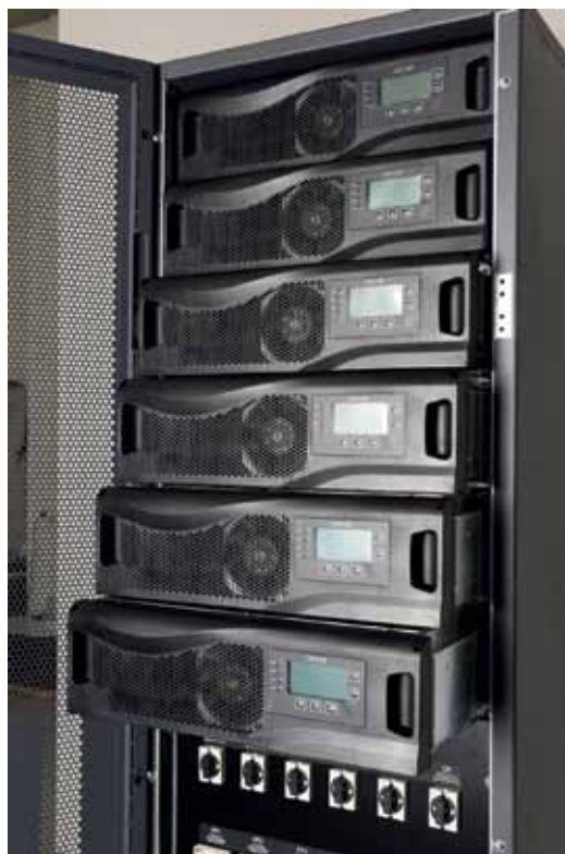
Рис. 2. ИБП 150 кВА без внутренних АКБ
