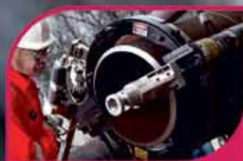
Отрезка труб и разделка кромок под сварку
