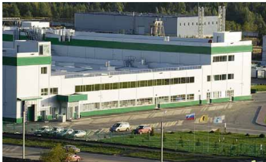
Рис. 1. Завод FlexFactory в Ярославле
