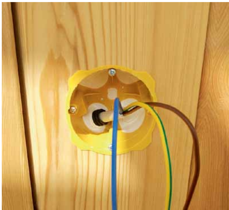
Рис. 1. Мембраны в подрозетниках KOPOS обеспечивают герметичность и удобство монтажа
