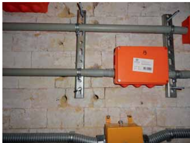
Рис. 4. Монтаж линий ОКЛ «Промрукав» в испытательной печи
