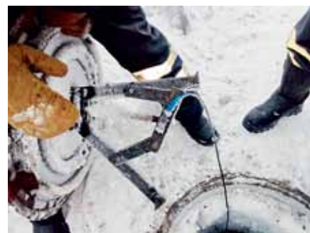
Рис. 1. Датчики системы «СОКОЛ», установленные на устройствах запираания крышки люка: ДАК — с помощью комплекта крепления (слева); ДСА — с помощью крепежной ленты и саморезов (справа)
