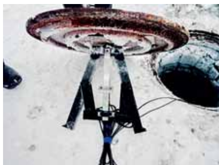
Рис. 1. Датчики системы «СОКОЛ», установленные на устройствах запираания крышки люка: ДАК — с помощью комплекта крепления (слева); ДСА — с помощью крепежной ленты и саморезов (справа)
