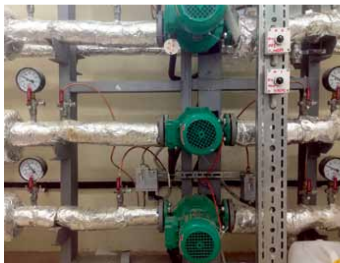
Рис. 4. Примеры размещения основного и резервного циркуляционных насосов и датчиков-реле для их контроля
