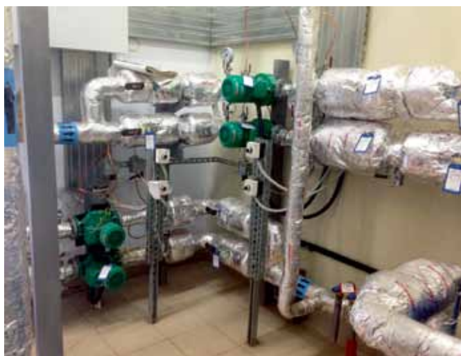
Рис. 4. Примеры размещения основного и резервного циркуляционных насосов и датчиков-реле для их контроля
